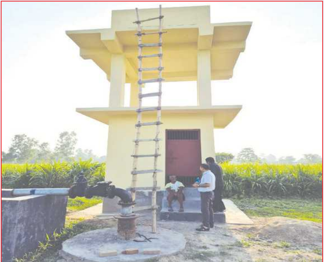
डिप ट्यूबवेल जडान, तथा पम्पहाउस निर्माण कार्य, गौशाला - ४, महोत्तरी
